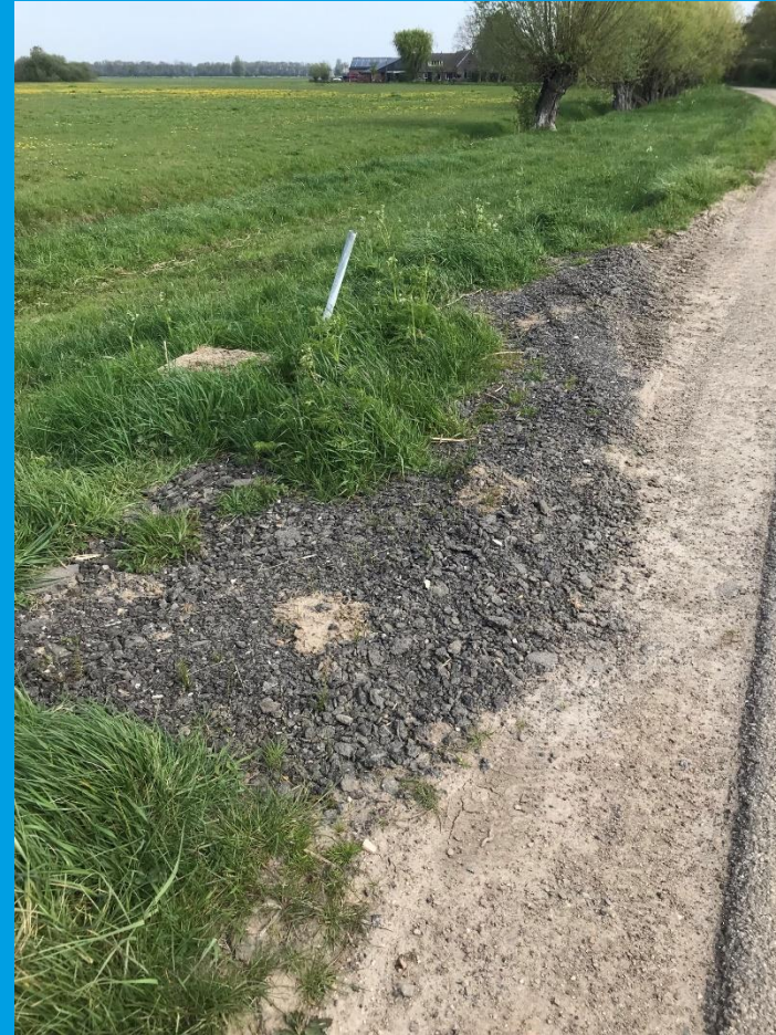
Asfaltgranulaat vermengd met de bodem
