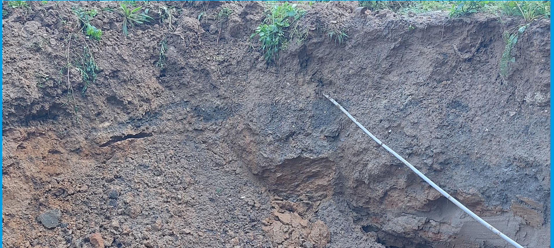
Saneringsput van eerder foutief aangebracht immobilisaat
