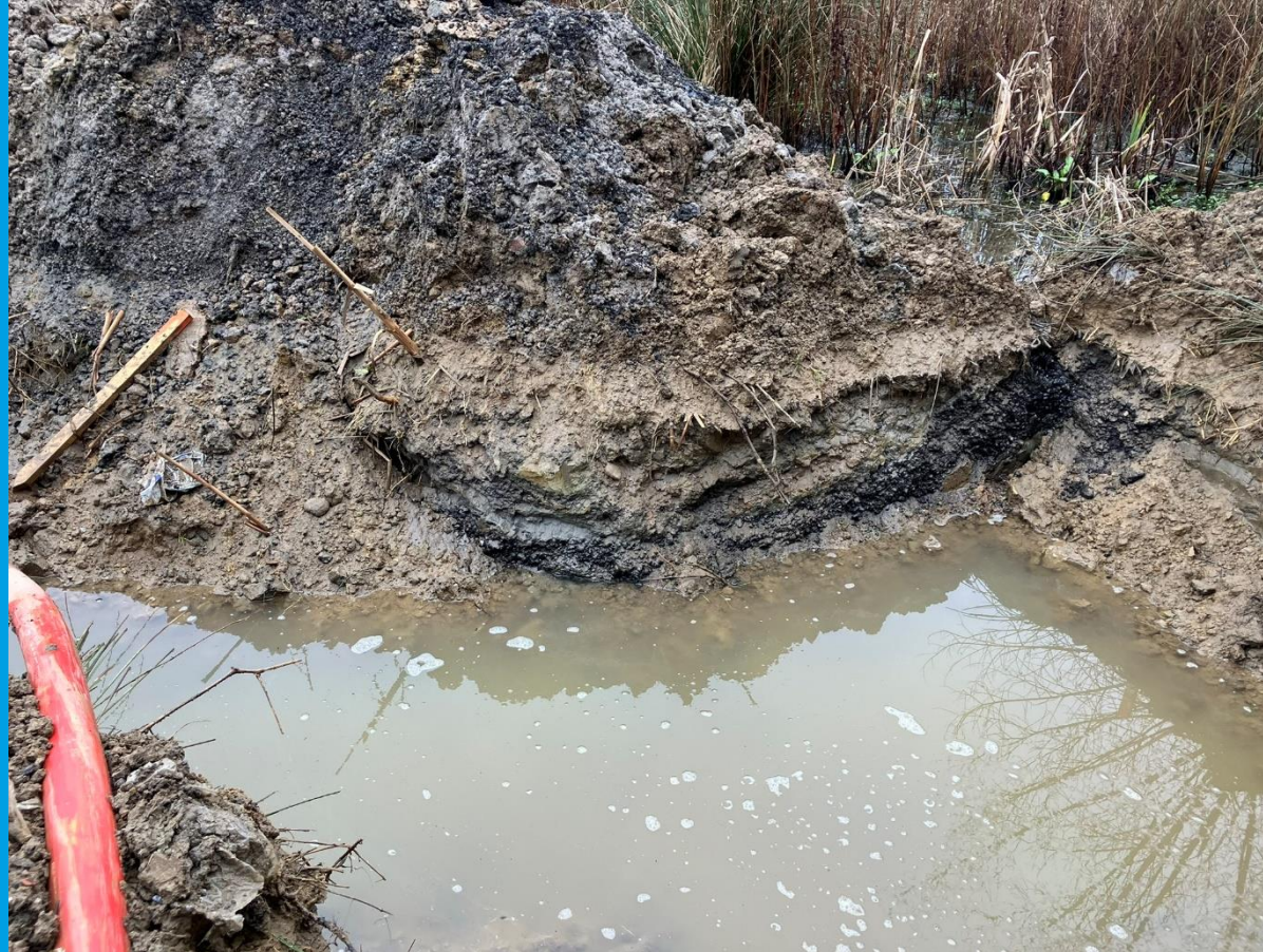
Saneringsput van eerder foutief aangebracht immobilisaat
