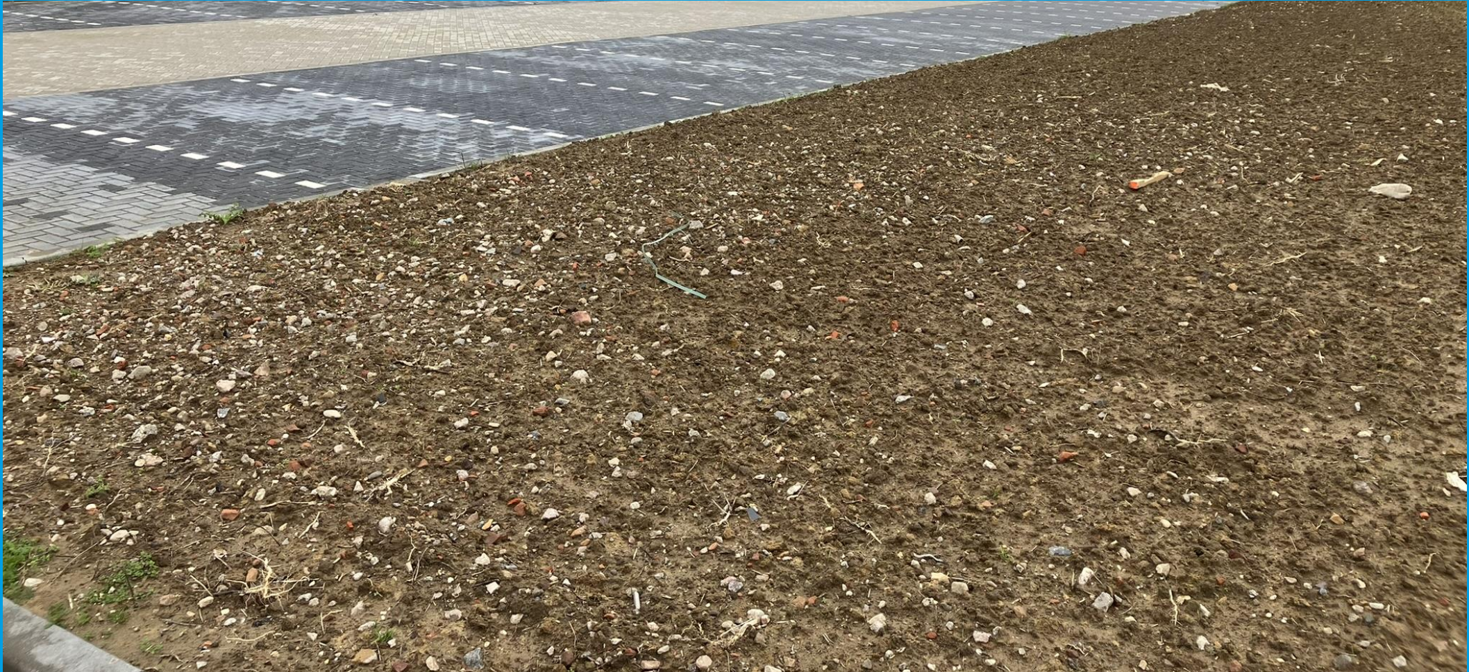
Vermenging menggranulaat in groenstrook
