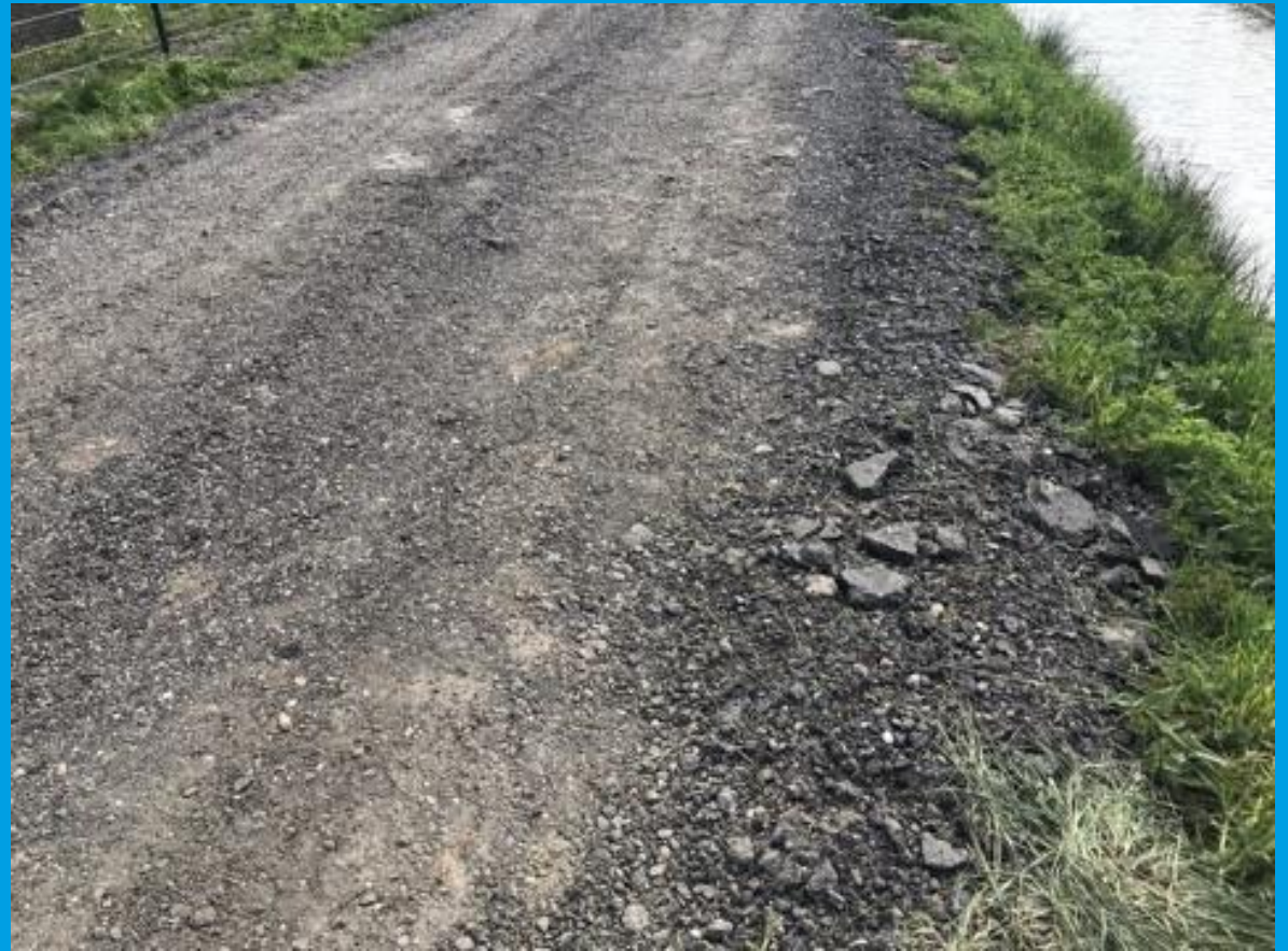
Toepassing met asfaltgranulaat
