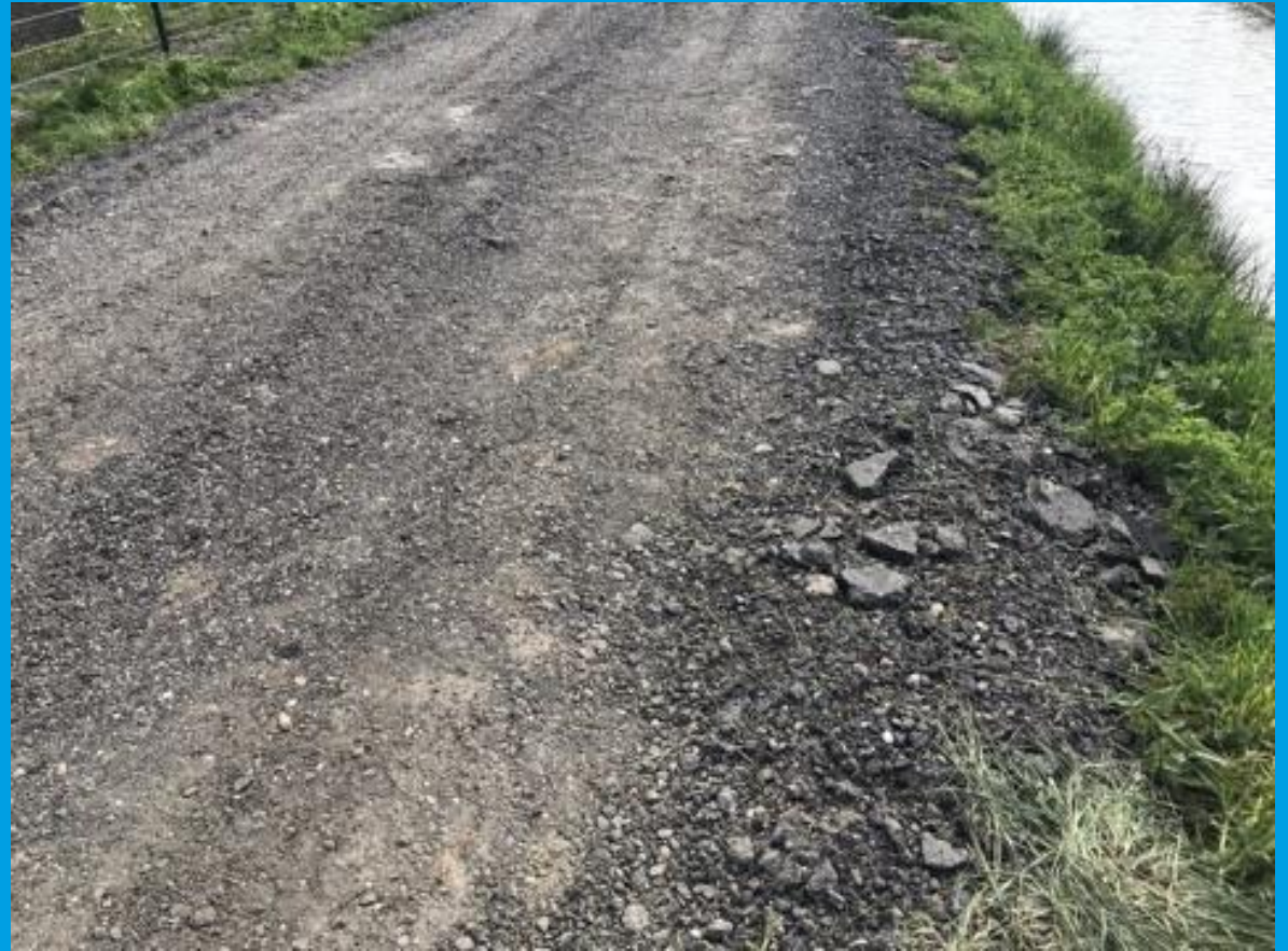
Toepassing met asfaltgranulaat
