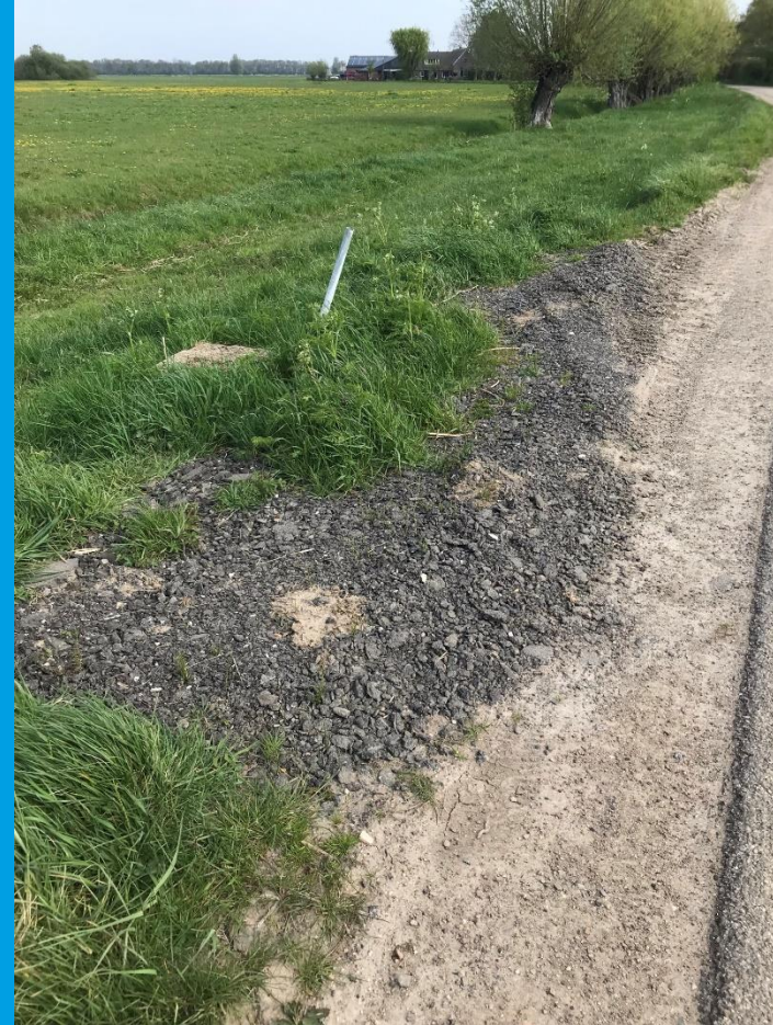
Asfaltgranulaat vermengd met de bodem
