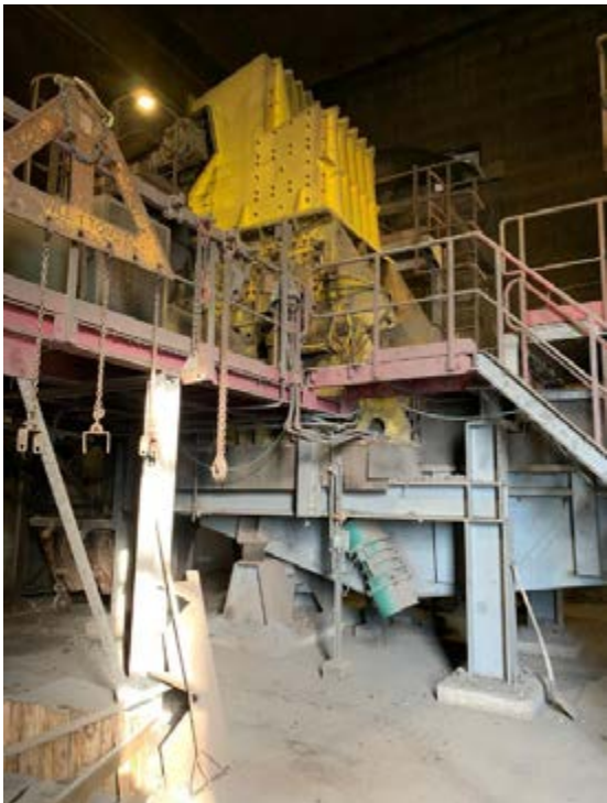
Gedeelte van de verwerkingsinstallatie
