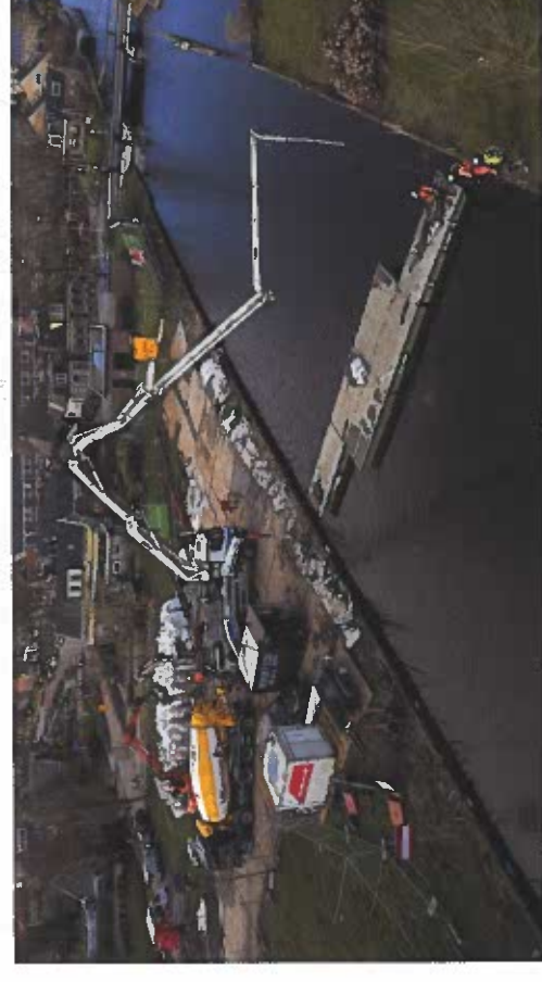
Het vullen van de reeds afgezinkten matten.
