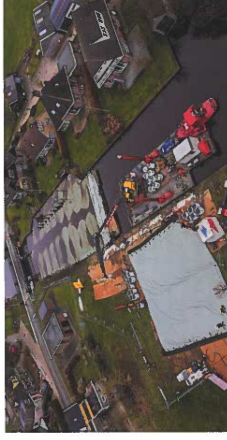
Het leggen van de matten vlak voor het afzinken.
